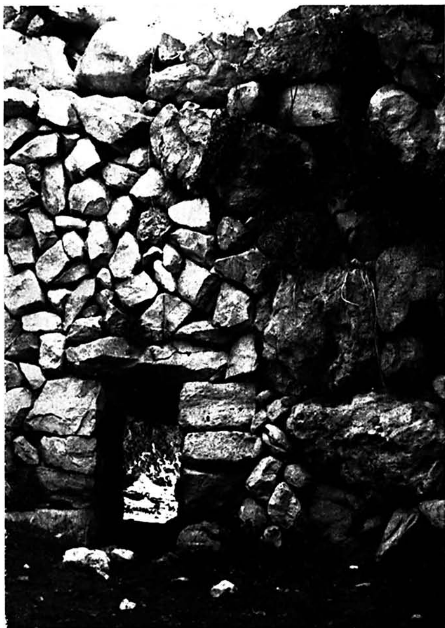
Vista interior del segundo portal de ingreso a la cámara del talayot de Son Coll Nou (Algaida), en la que puede apreciarse muy bien la parte reconstruida.
