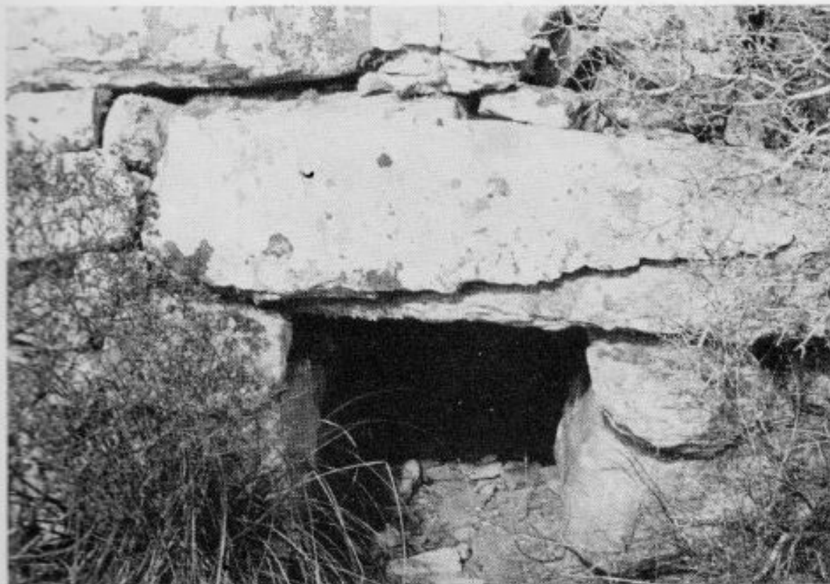
Otro portal de entrada a la cámara inferior del talaiot de Es Rafal Roig.
